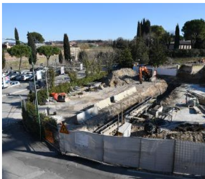
L'area dov'è stata abbattuta l'ex casa di riposo di Peschiera
