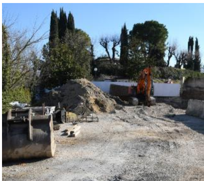
È stato rimosso tutto, comprese le fondamenta. FOTO PECORA
