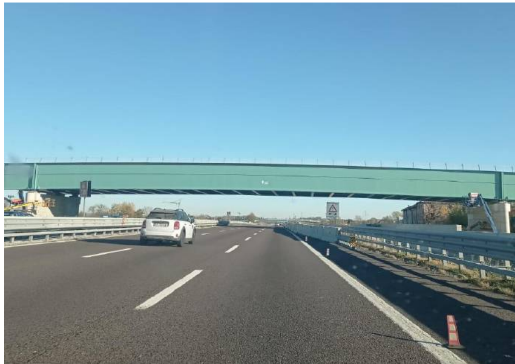
Le opere in corso al cavalcavia in località Roveglia a Pozzolengo
